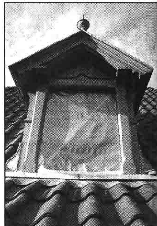
Schmucke Gauben und alte Balken blieben im neuen Dach.
